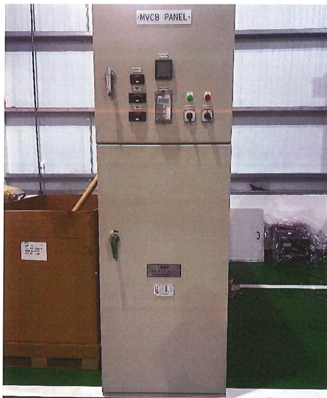
圖 1 高壓配電盤
