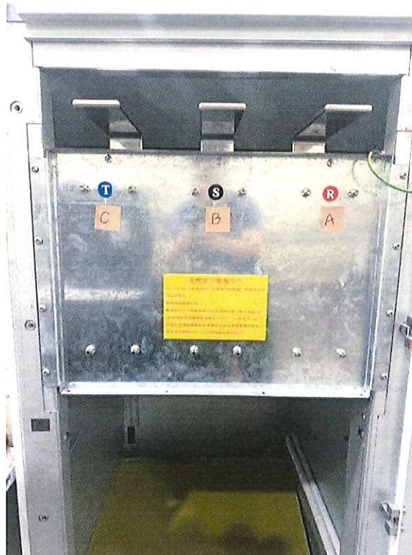
圖 3 高壓配電盤負載側接點
